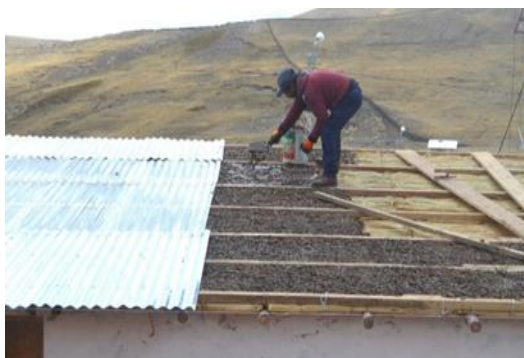
Figura 7. Capa aislante del techo: panel de totora y planchas de tierra alivianada.
