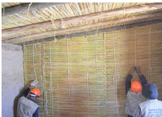
Figura 5. Aislamiento interior con fibra de "totora".
