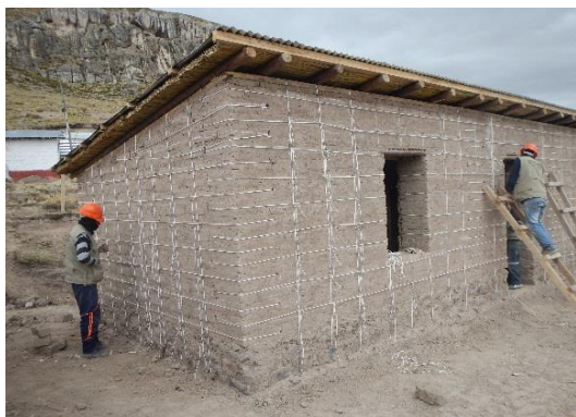
Figura 6. Refuerzo sismo resistente con soga de nylon.
